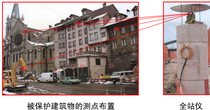
图29-41现场自动监测实景
