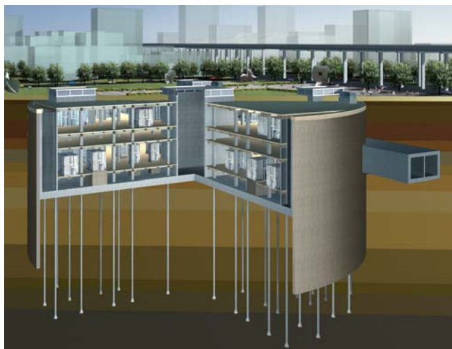
图 18-51 上海世博 500kV 地下变电站效果图
