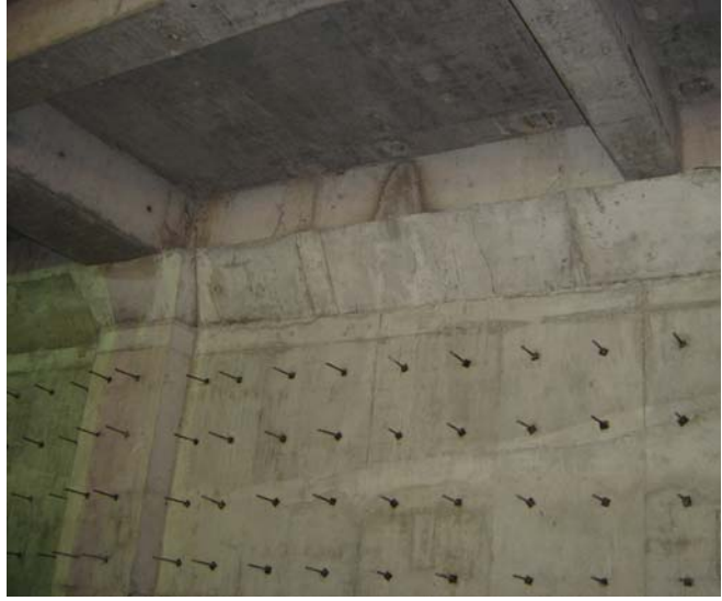
图 18-30 剪力墙逆作施工完成后的实景图
