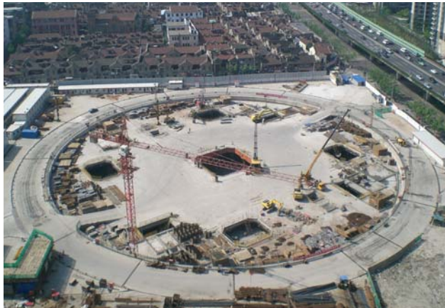
图 18-62 逆作阶段顶层结构实景
