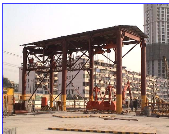
图 18-34 取土架在进行施工作业
