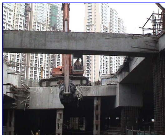
图 18-33 长臂挖机在进行施工作业
