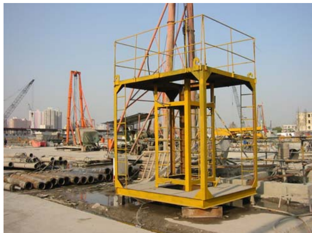
图 18-17 “一柱一桩”纠正架图
