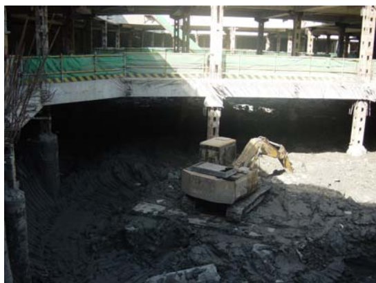
图 18-31 小型挖机在坑内暗挖作业
