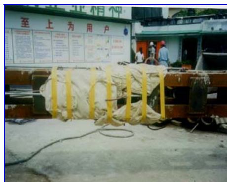
图 18-13 气囊施工实例图
