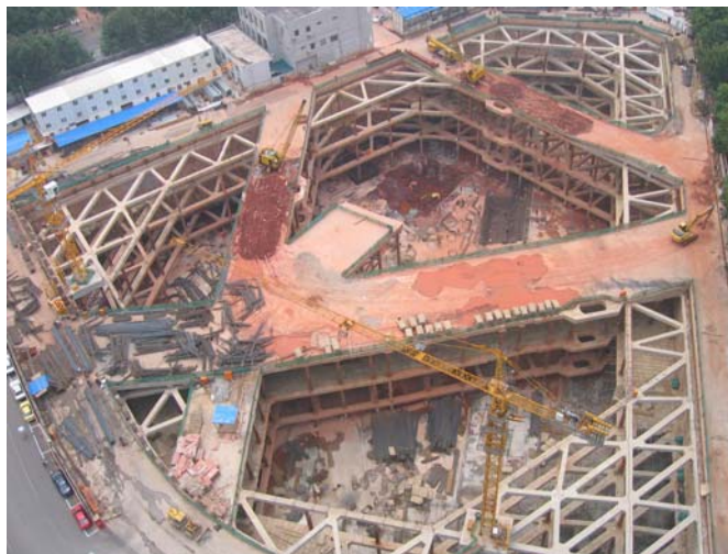
图 18-41 基坑开挖到底时的支撑情况
