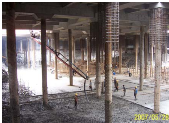
图 18-60 钢管混凝土柱实景
