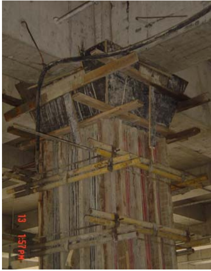
图 18-29 逆作立柱模板支撑实景图
