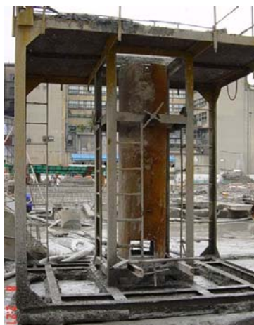
图 18-16 钢管纠正架图
