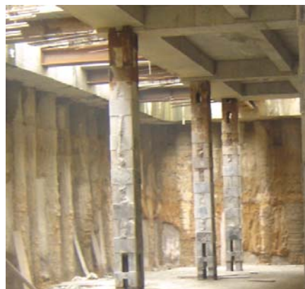
图18-47 边跨结构竖向支承现场照片
