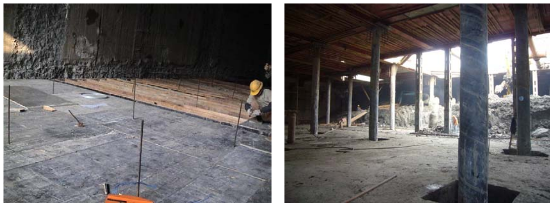
图 18-27 无排吊模施工实景图
