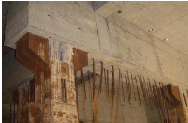
图18-46 剪力墙托换节点现场照片
