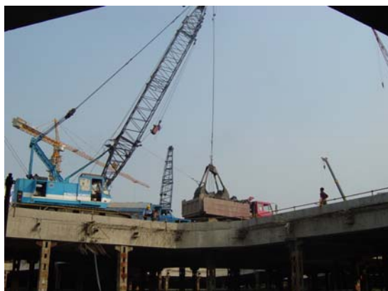
图 18-32 吊机在吊运土方
