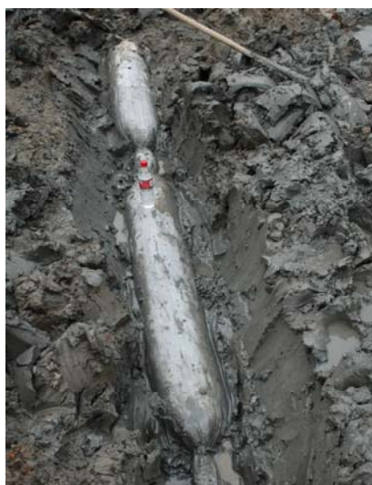
错误！未找到引用源。 现场开挖的注浆体
