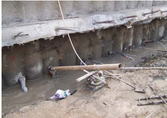
错误！未找到引用源。 地下水水位高于孔口标高的最下一排锚杆钻孔
